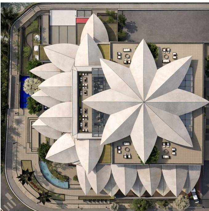
VISTA DESDE EL TECHO
